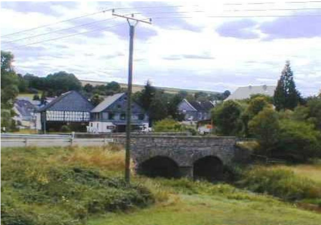
Diese Brücke in Oberkirm führt über den Kyrbach. Das verwendete Material für diesen zweibogigen Brückenbau nennt man Schieferbruchstein.
